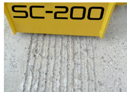
Scarificazione, scanalatura, rimozione del calcestruzzo.
