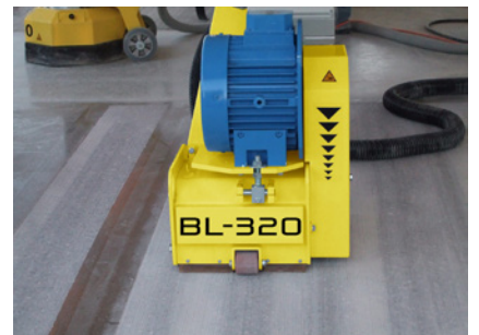
Correzione superficiale di precisione su pavimento in cemento
