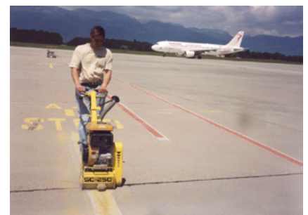
Rimozione della segnaletica.
