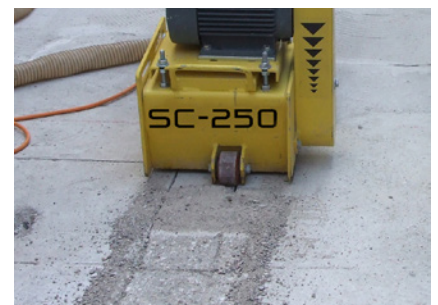
Preparazione superfici in calcestruzzo – irruvidimento.
