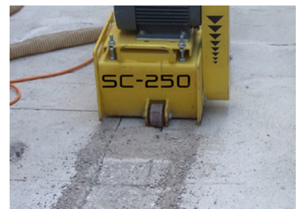
Preparazione superfici in calcestruzzo – irruvidimento.
