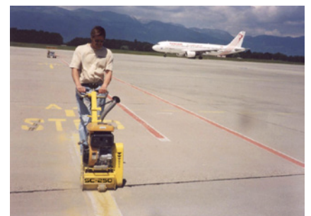
Rimozione della segnaletica.
