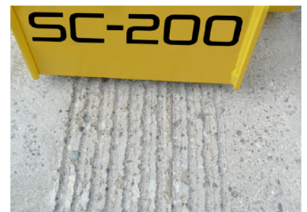
Scarificazione, scanalatura, rimozione del calcestruzzo.
