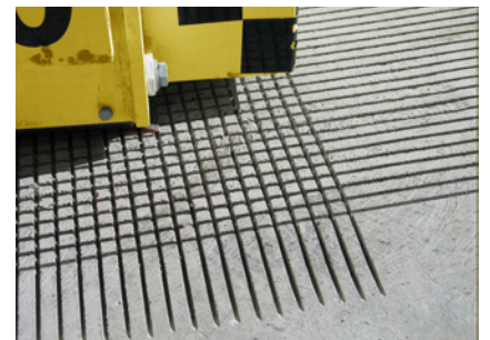
Preparazione della superficie – Irruvidimento del calcestruzzo
